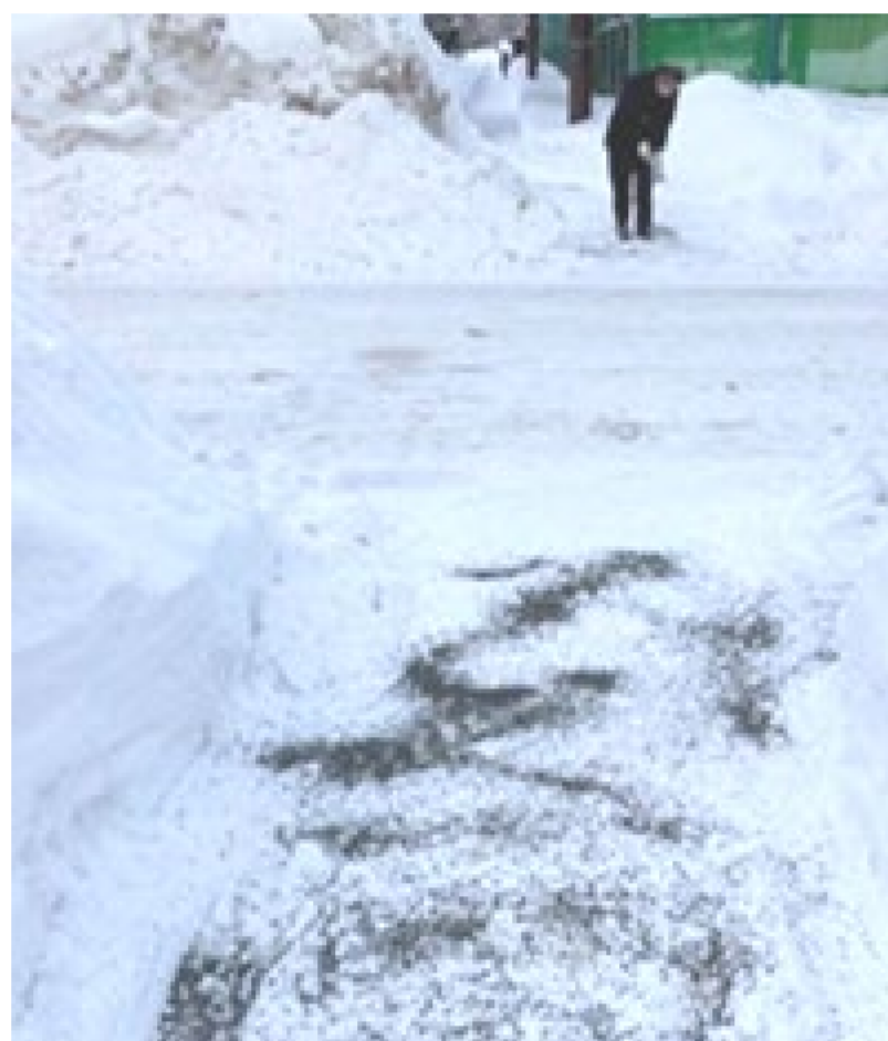
①滑る路面(つるつる路面)に砂を撒きます。
