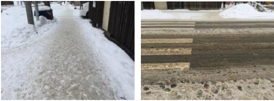
図 9 平成 29 年 12 月 12 日の路面状況 (北 12 条駅付近)
