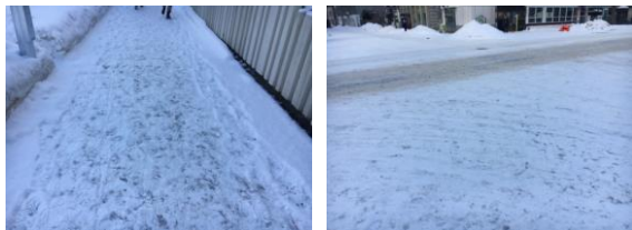
図 11 平成 30 年 1 月 12 日の路面状況 (北 12 条駅付近)
