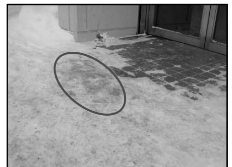
写真 3 地下街からの出口付近 周囲は圧雪だが、出口から一歩目の部分だけがつるつるになっている
