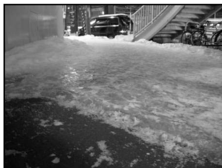
写真 2 ロードヒーティングとの接点 周囲は滑らないが、ロードヒーティングとの連続箇所はつるつる路面に
