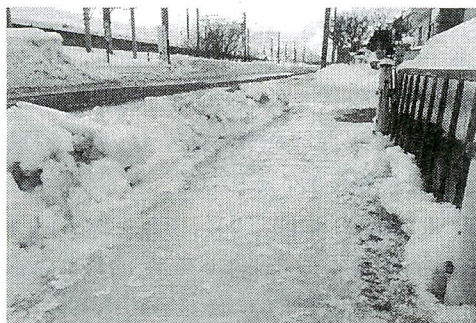
図2 氷板が形成された歩道。氷板は周囲の雪に比べると、光の散乱が押さえられ灰色っぽく見える。
