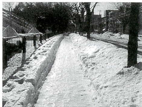
図3 圧雪表面が氷膜化した歩道。薄い氷膜を通して内部の圧雪が透けて見えるため、白っぽく見える。
