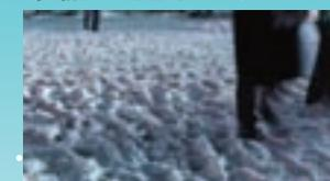
雪开始融化时,由于行人和车辆的踩压而变成了类似砂糖状态,所谓的“砂糖型路面”。
